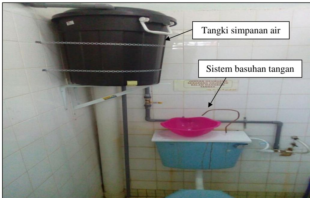
**Rajah 3:** Pemasangan tangki simpanan air dan sistem basuhan tangan yang terletak di atas tangki simbah tandas.
