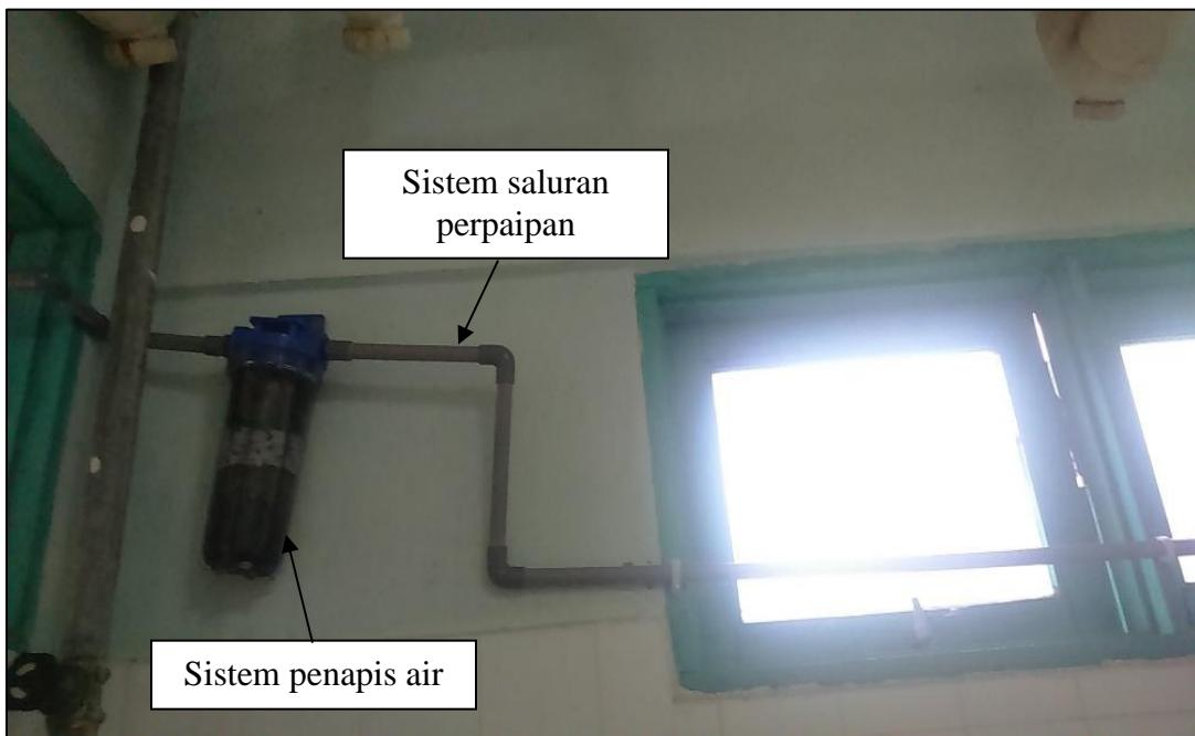
**Rajah 2:** Sistem penapis air yang terdiri daripada batu baur kasar, batu baur halus dan arang yang dipasang pada sistem perpaipan untuk inovasi ini.
